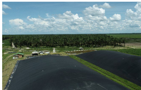
Planta de generación de biogás a partir de la captura de gas metano. Manuelita Aceites y Energía. San Carlos de Guaroa, Meta.
